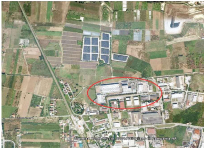
Impianto di tritovagliatura di Giugliano
