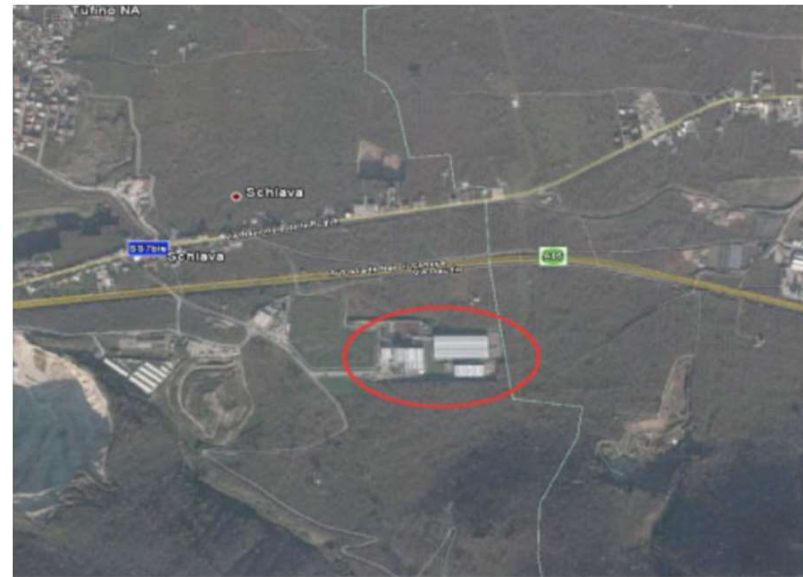
Impianto di tritovagliatura di Tufino
